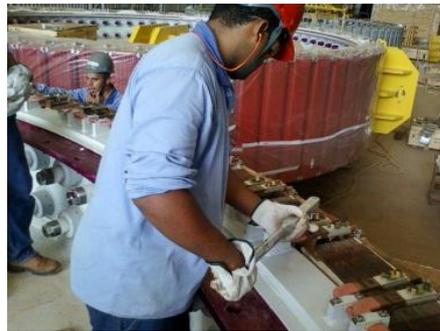
Torque das conexões isoladas
